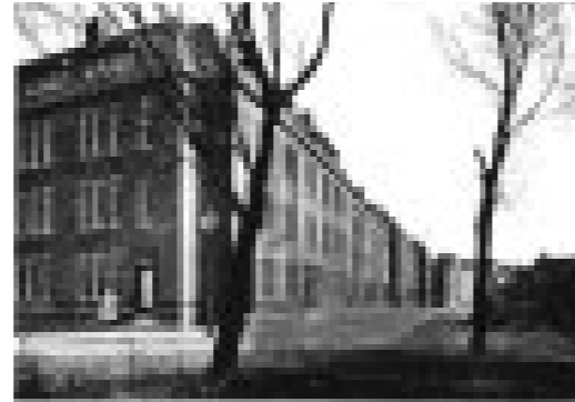
Bloque V de las viviendas del distrito de Spangen
