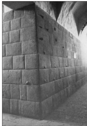
Muro interior. Qoricancha
